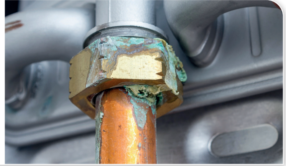
الشكل (19): تآكل فلزّ النحاس.
